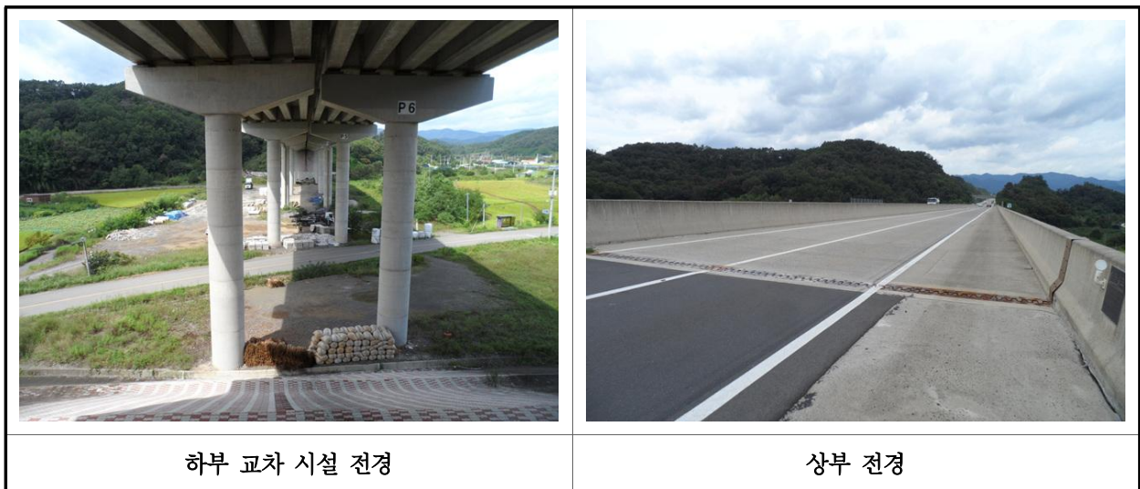
【사진 31.2.1】 부재 현장측정 전경
