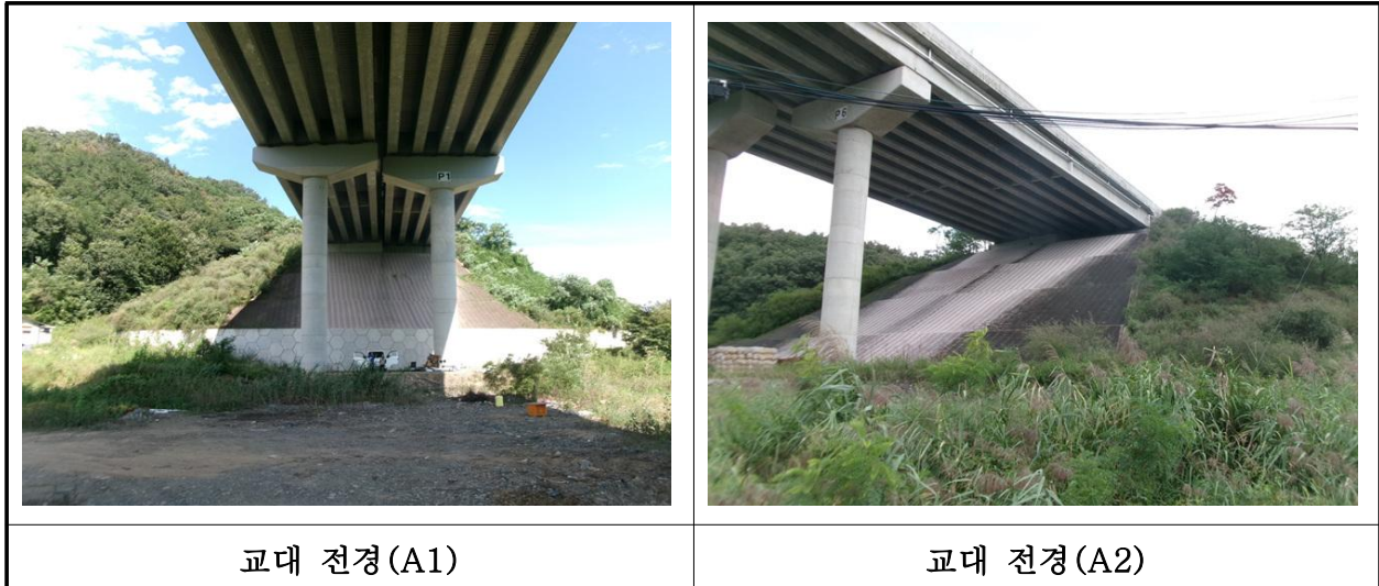
【사진 31.3.38】 교대 전경
