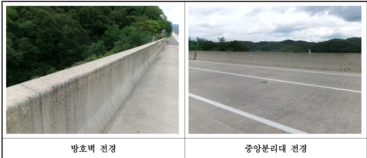
【사진 31.3.58】 방호벽 및 중앙분리대 전경
