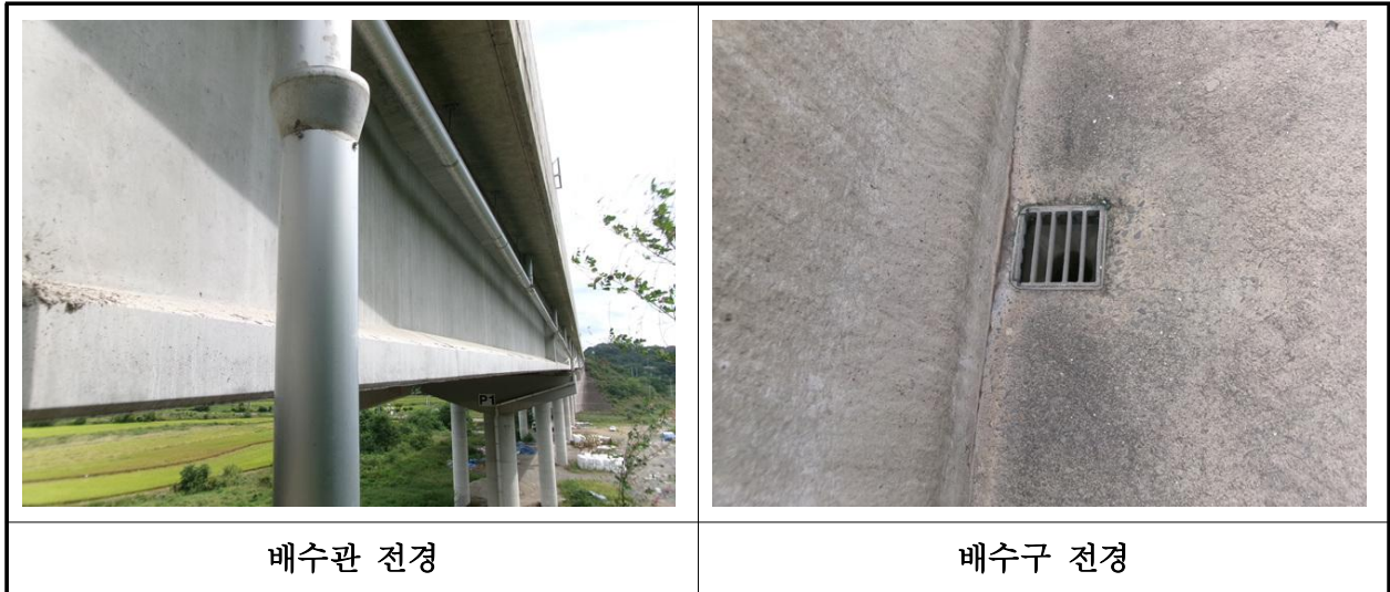
【사진 31.3.56】 배수시설 전경
