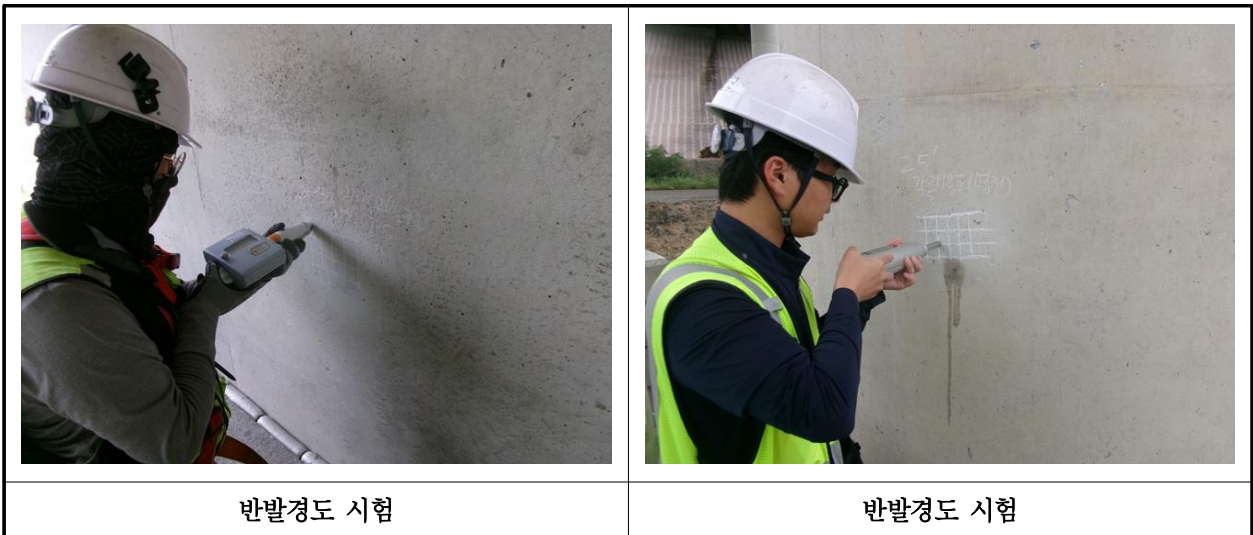
【사진 31.4.2】 반발경도시험 현장사진
