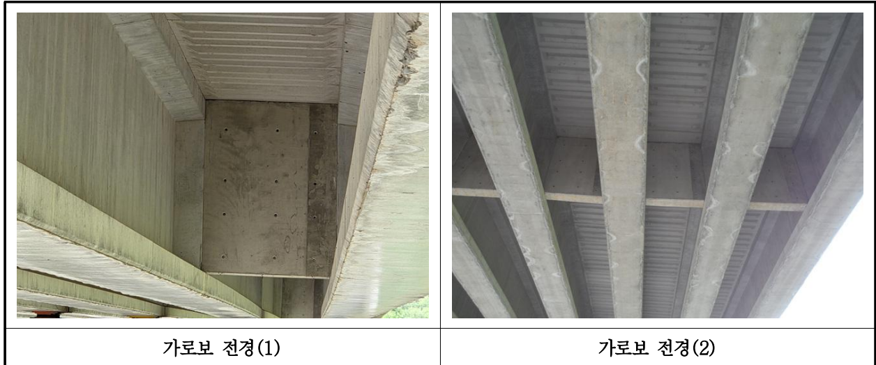
【사진 31.3.6】 가로보 전경
