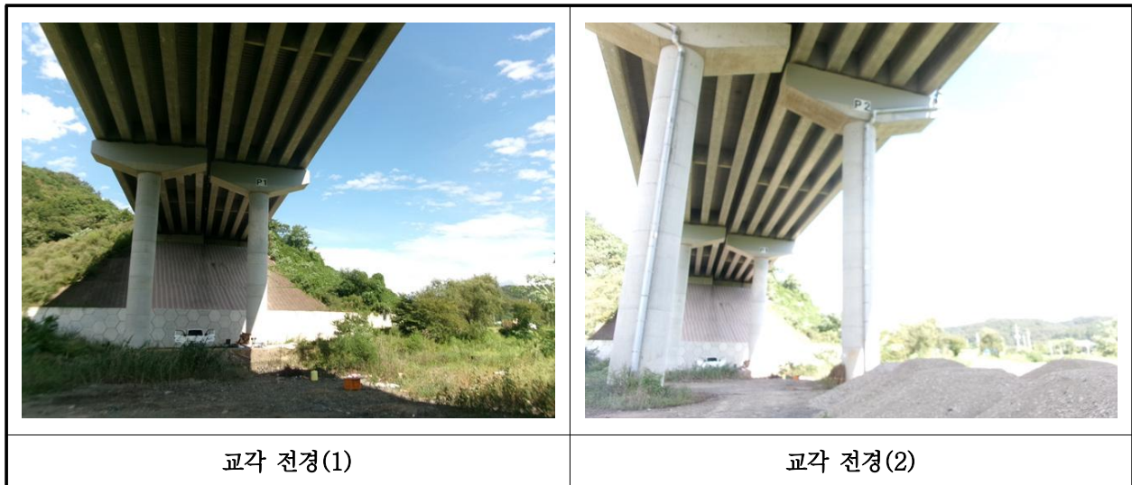
【사진 31.3.10】 교각 전경
