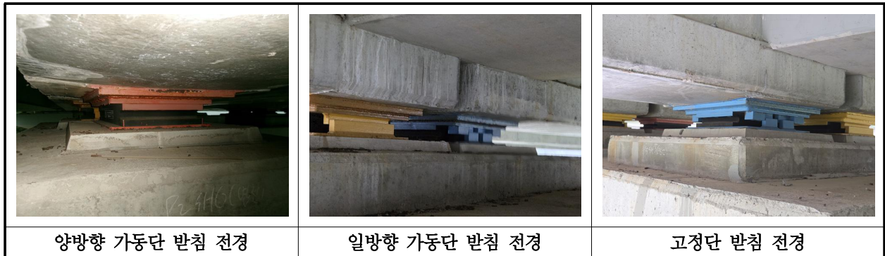
【사진 31.3.44】 교량반침 전경
