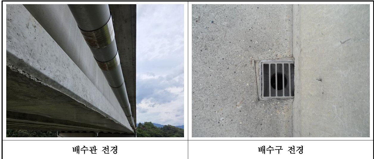
【사진 31.3.25】 배수시설 전경
