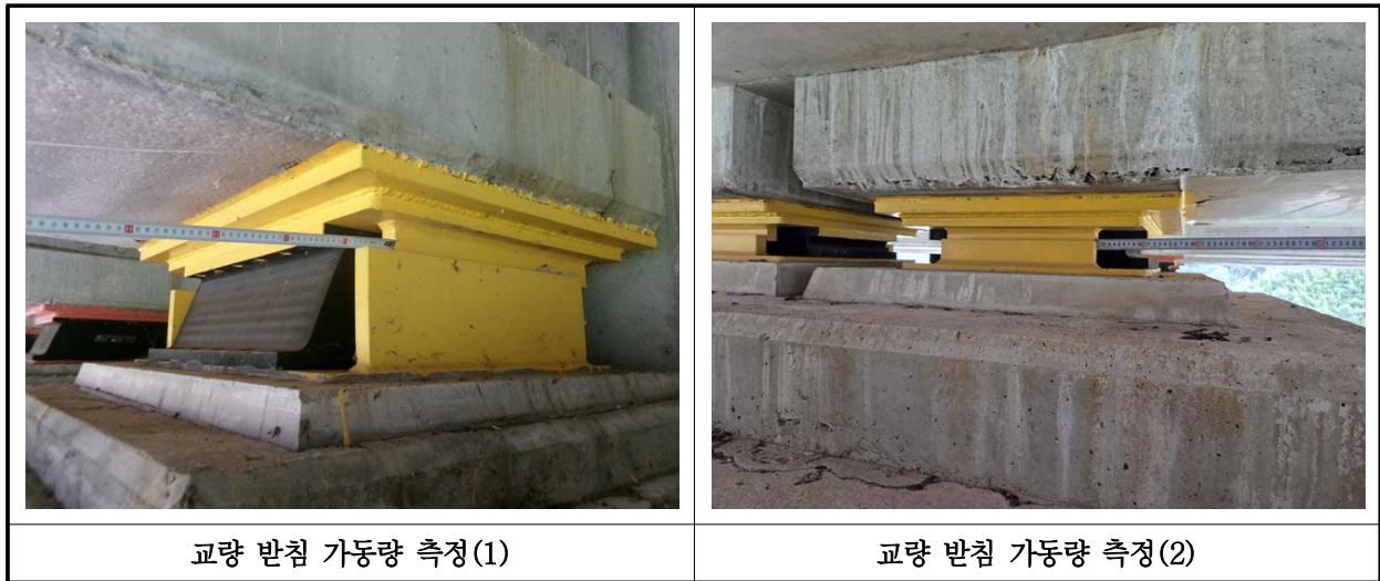
【사진 31.3.48】 교량받침 이동량 측정
