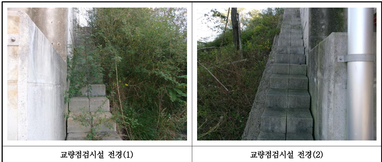
【사진 31.3.29】 교량 점검시설 전경
