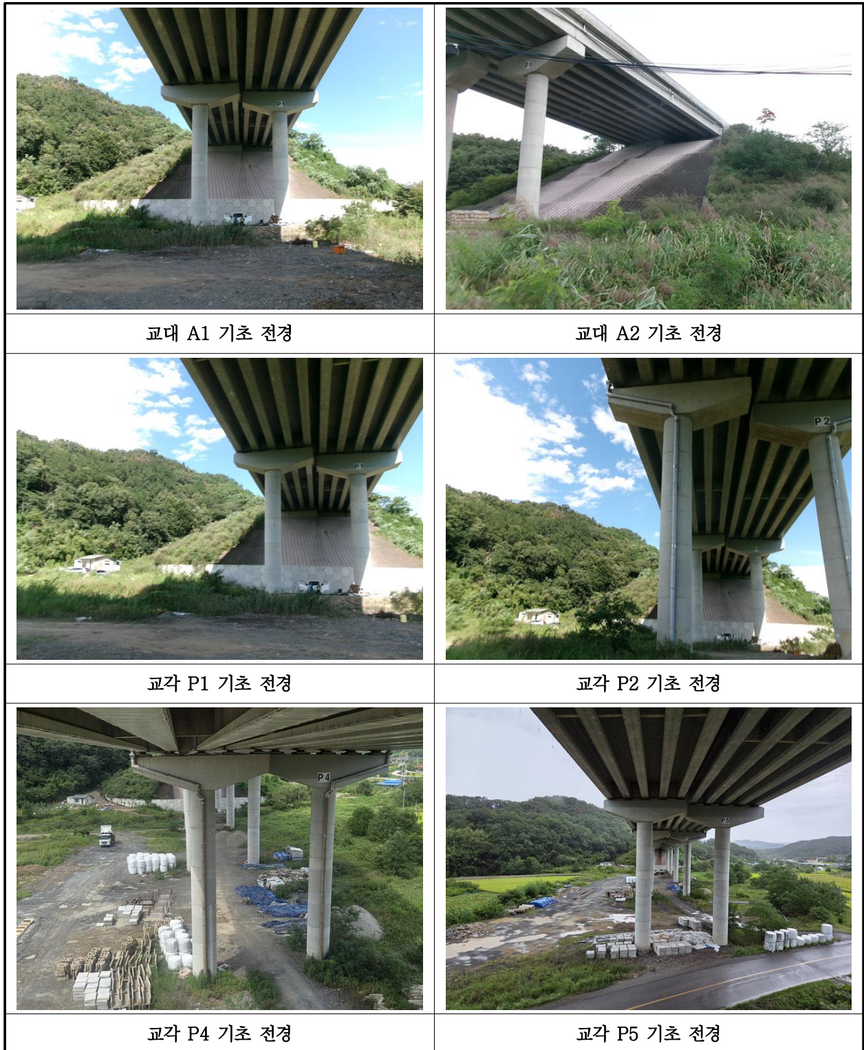
【사진 31.3.43】 기초 전경
