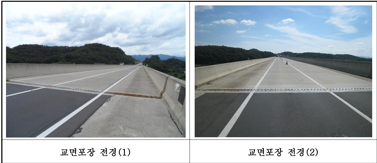
【사진 31.3.22】 교면포장 전경
