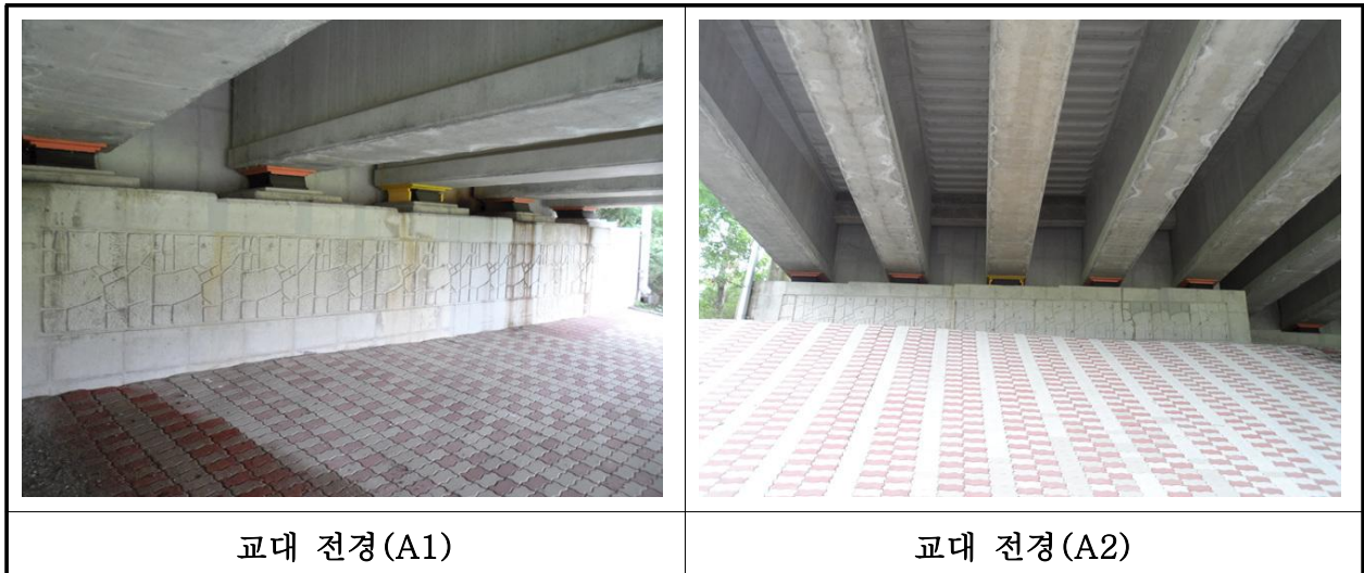
【사진 31.3.8】 교대 전경
