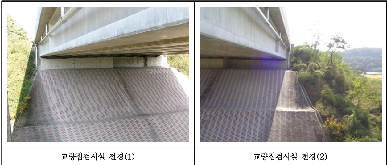
【사진 31.3.60】 교량 점검시설 전경
