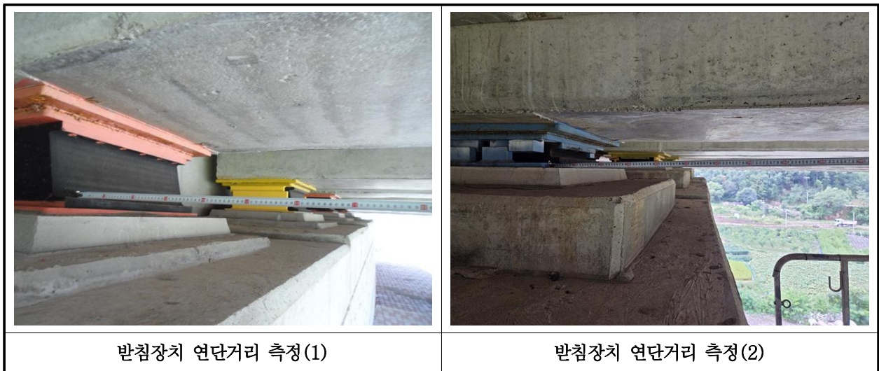
【사진 31.3.16】 교량받침장치 연단거리측정
