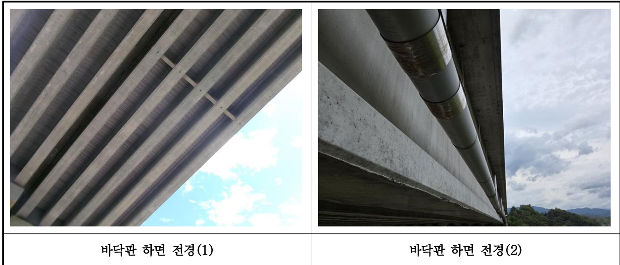
【사진 31.3.2】 바닥판하면 전경
