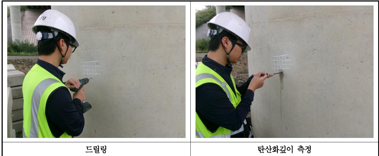
【사진 31.4.3】 탄산화 깊이 측정 현장사진
