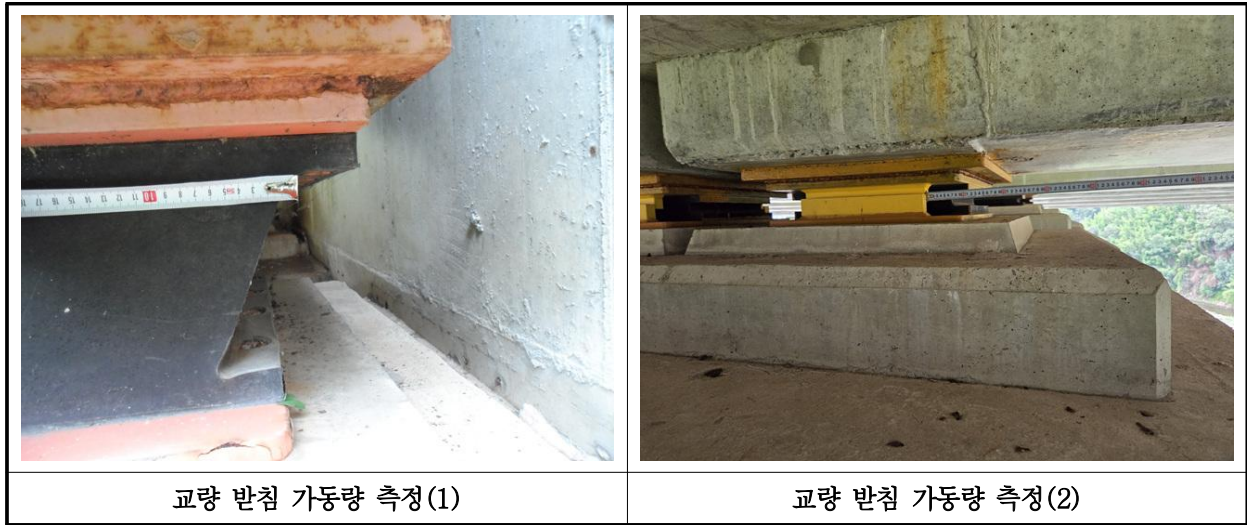
【사진 31.3.17】 교량받침 이동량 측정
