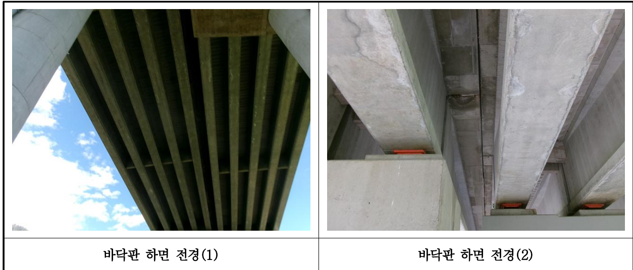
【사진 31.3.32】 바닥판하면 전경
