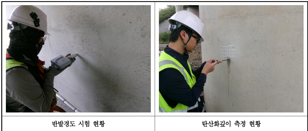
【사진 31.4.1】 콘크리트 내구성조사 현황
