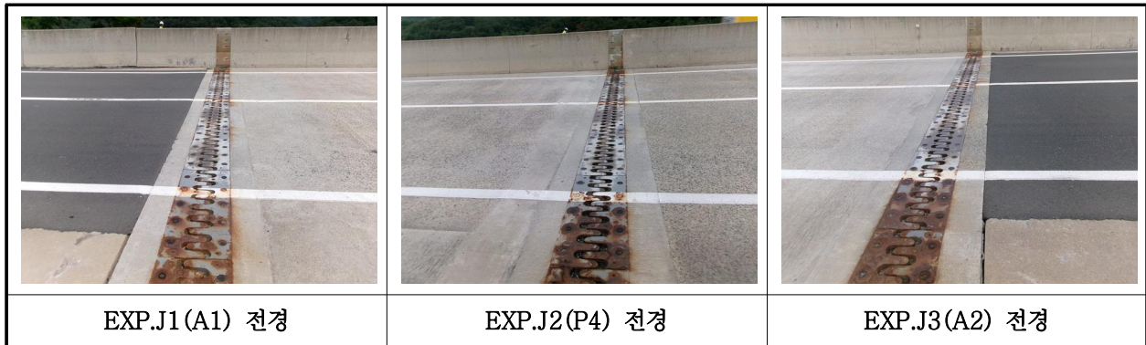
【사진 31.3.49】 신축이음장치 전경
