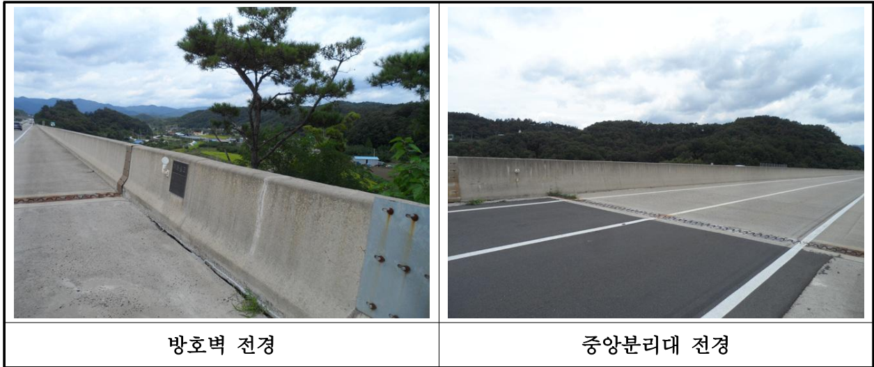
【사진 31.3.27】 방호벽 및 중앙분리대 전경
