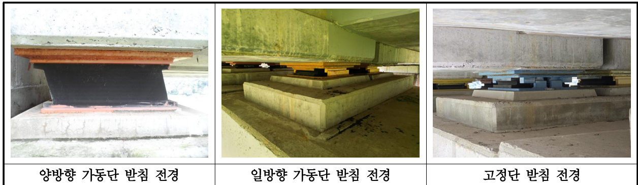
【사진 31.3.13】 교량반침 전경
