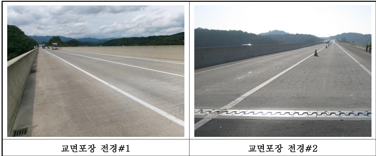
【사진 31.3.53】 교면포장 전경
